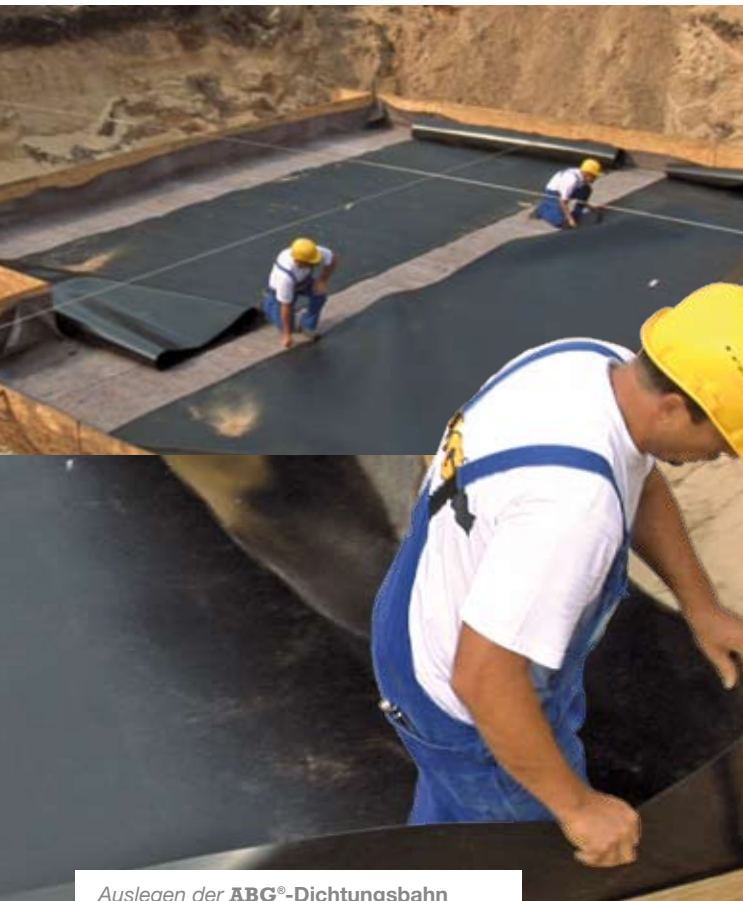
Auslegen der ABG®-Dichtungsbahn
