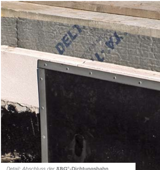
Detail: Abschluss der ABG®-Dichtungsbahn
