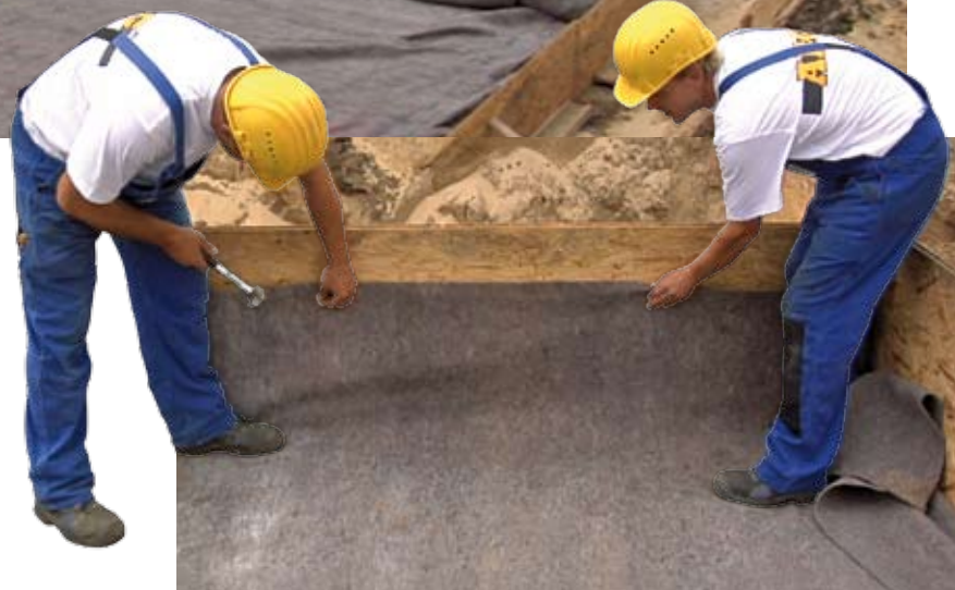
Auslegen des Schutzvlies
