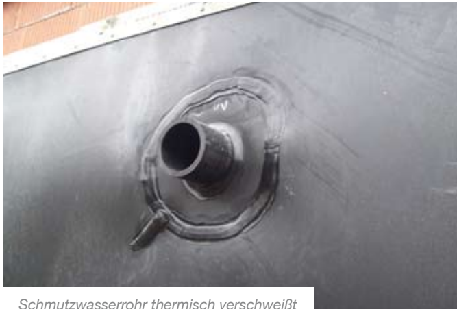
Schmutzwasserrohr thermisch verschweißt
