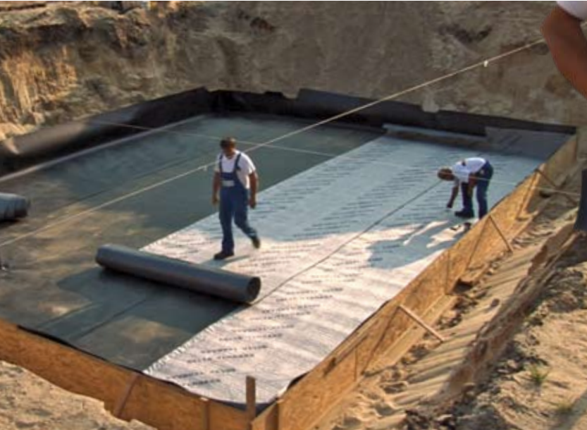
Auslegen der ABG®-Atmungsfixbahn
