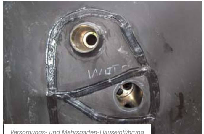
Versorgungs- und Mehrsparten-Hauseinführung
