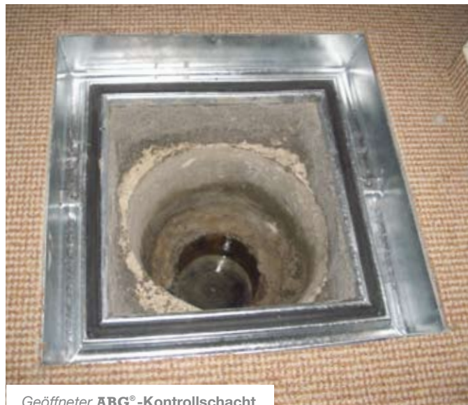
Geöffneter ABG®-Kontrollschacht
